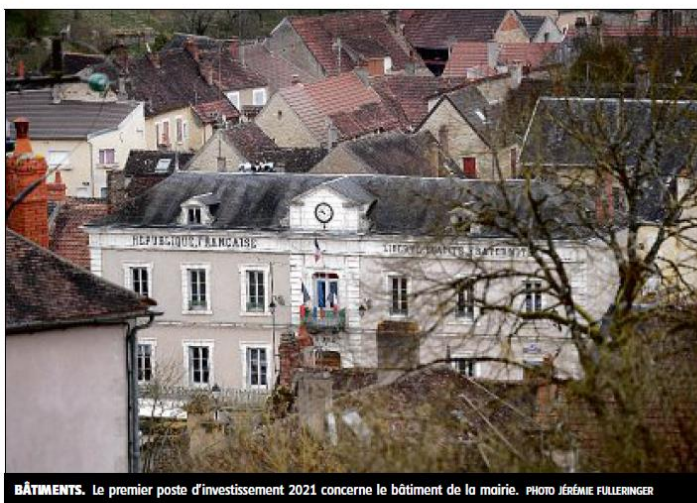
BÂTIMENTS. Le premier poste d'investissement 2021 concerne le bâtiment de la mairie. PHOTO JÉRÉMIE FULLERINGER
