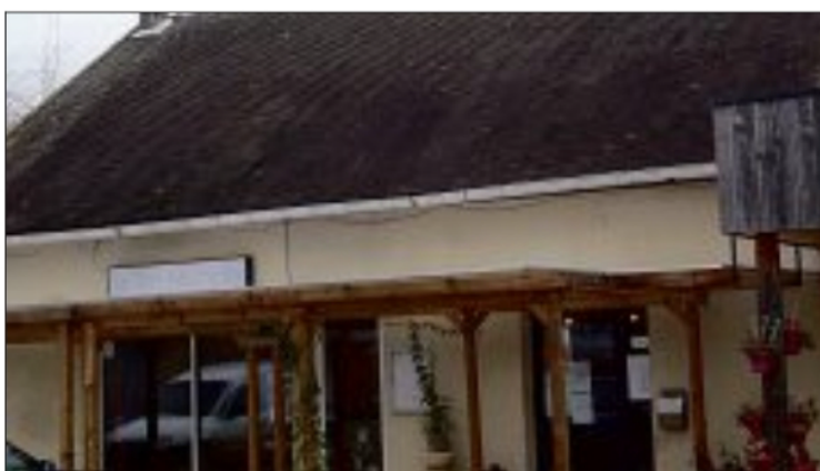
TRAVAUX. Des panneaux photovoltaïques pourraient être posés sur le toit du café-commerce.
