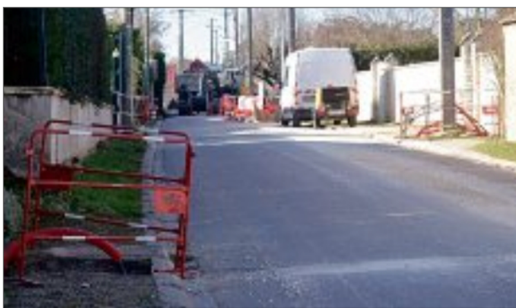
CHANTIER. Les travaux se poursuivent, route de Nailly.
