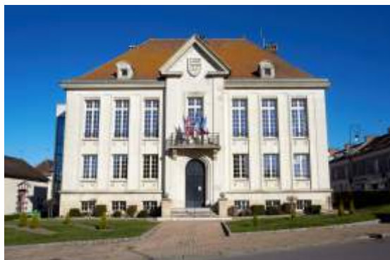
Montholon – bâtiment Mairie Aillant sur Tholon
